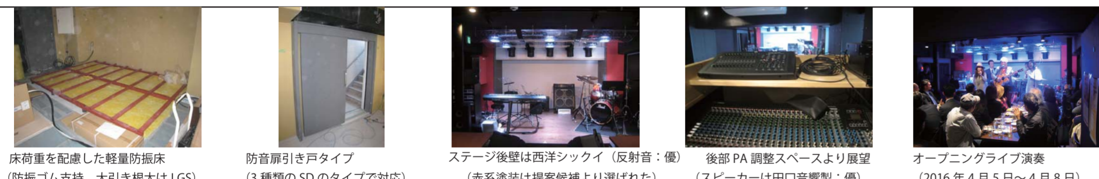
床荷重を配慮した軽量防振床（防振ゴム支持、大引き根太は LGS） 浮き天井仕様（防振ゴムハンガー、LGS、PB、岩面吸音板） 浮き壁仕様（LGS、PB2 重張り、グラスウール） 給・排気用消音装置（新設計） 竣工 2012 年 12 月
