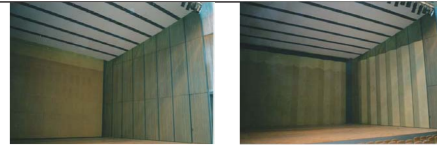
(イ) プロセニウム（舞台周り）の壁をリバーシブルにした 1. 講演会パターン 2. コンサートパターン (ロ) 角度を付け隙間を少なくしたボイド型天井
