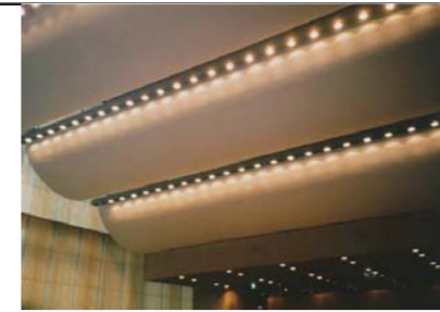
(イ) プロセニウム（舞台周り）の壁をリバーシブルにした 1. 講演会パターン 2. コンサートパターン (ロ) 角度を付け隙間を少なくしたボイド型天井
